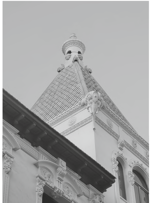
Detall de la teulada de la Casa de les Bruixes
